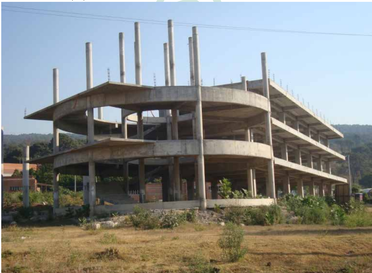
Fotografía 1. Construcción de la Facultad de Ciencias Químicas e Ingeniería
